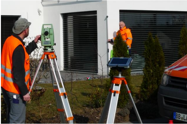
Einmessung der Lage des Gebäudes
