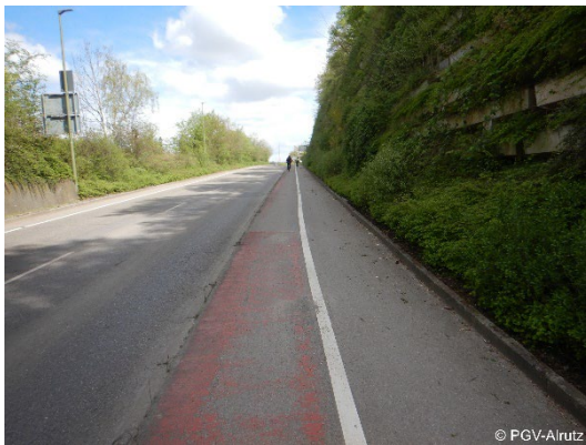
Abb. 5-28: Beispiel zu schmale Radverkehrsanlagen innerorts (Römerstraße, Leonberg)
