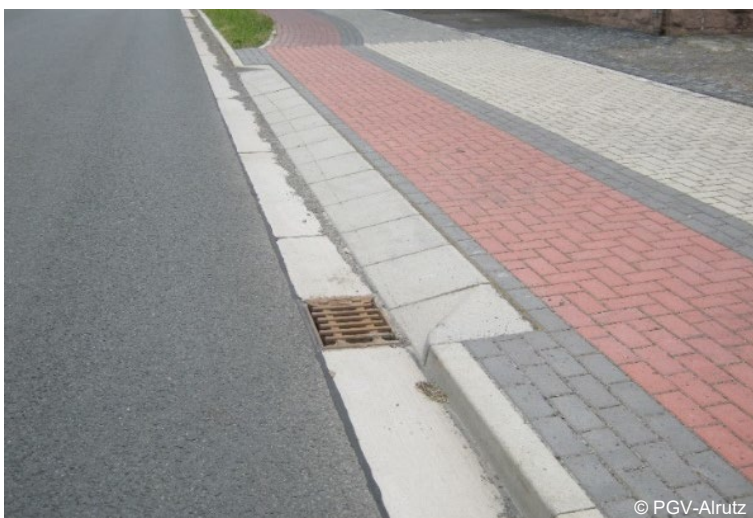
Abb. 5-6: Baulicher Einrichtungsradschweg mit Radwegüberfahrt an einer Grundstückszufahrt
