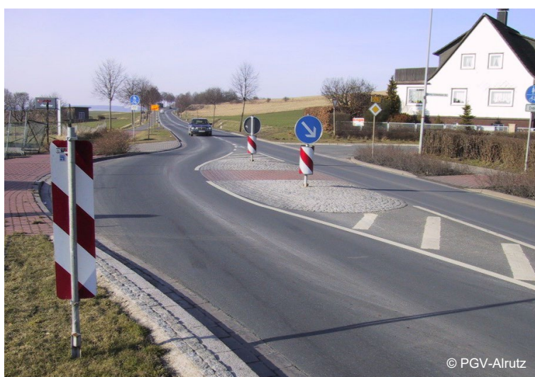
Abb. 5-25: Mittelinsel im Zuge einer Radverkehrsverbindung
