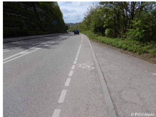
Abb. 5-28: Beispiel zu schmale Radverkehrsanlagen innerorts (Römerstraße, Leonberg)
