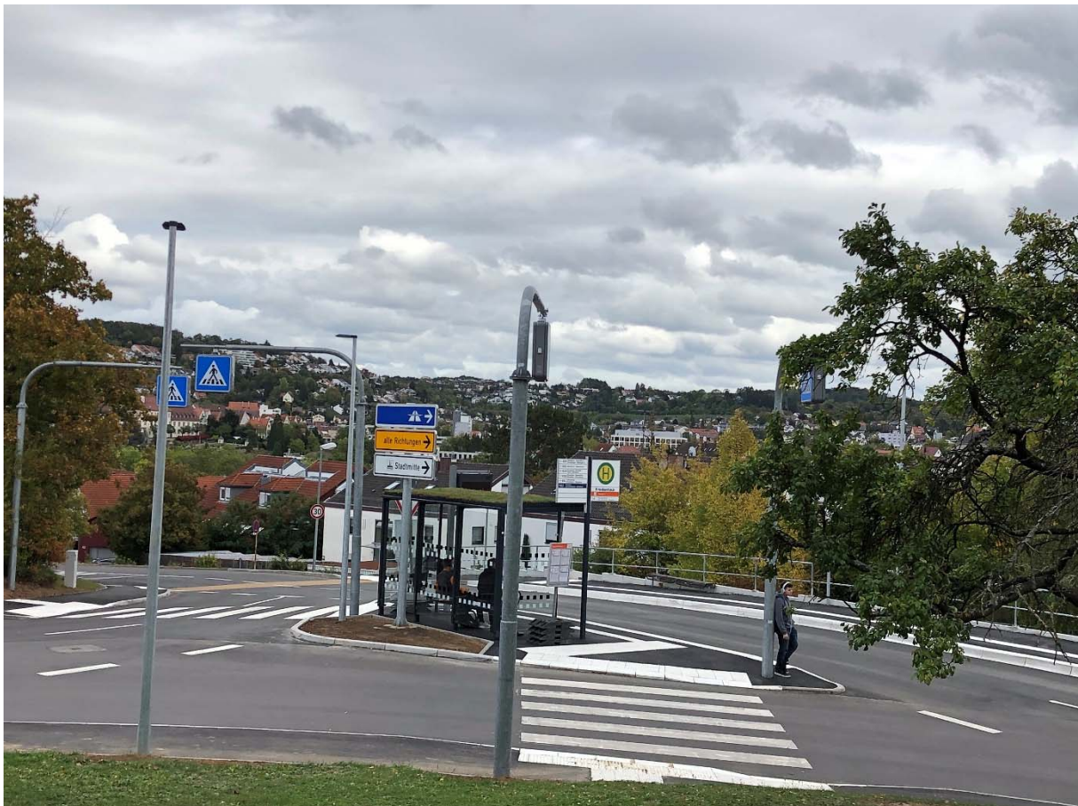
Neue Baustellenbereich Bushaltestelle Krankenhaus Leonberg
