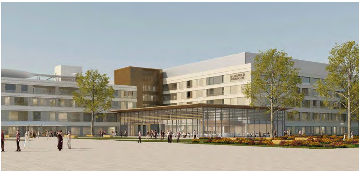
Blick auf das Flugfeldklinikum mit dem Haupteingang (Quelle: Gesamtprojektleitung Neubau Flugfeldklinikum)
