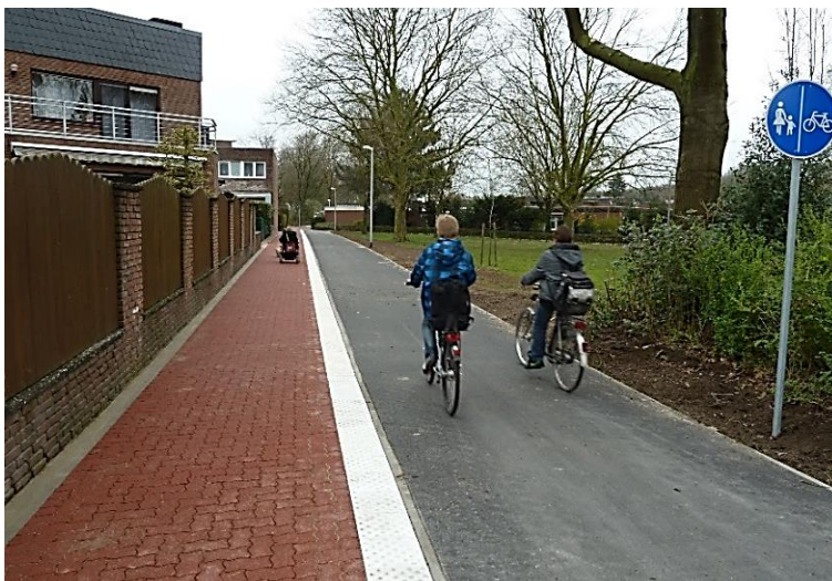
Abb. 5-16: Getrennter Geh- und Radweg. Trennung der Verkehrsarten durch einen taktil erfassbaren Trennstreifen (Foto Wilhelm Angenendt)
