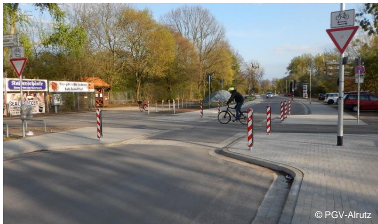
Abb. 5-24: Betonung des Vorrangs der Radverkehrsverbindung durch deutliche Fahrbahneinengung und Aufpflasterung
