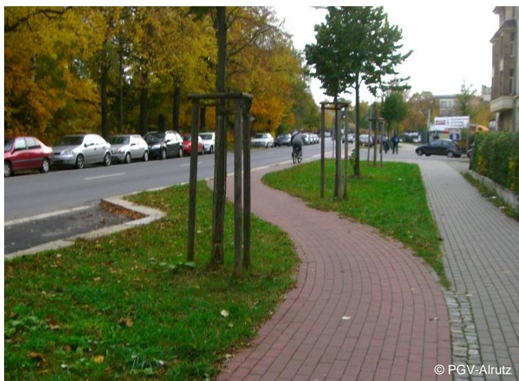
Abb. 5-20: Heranführen eines Radwegs an die Vorfahrtstraße, um die Sichtbeziehungen zwischen rechtsabbiegenden Kfz und Radverkehr zu verbessern
