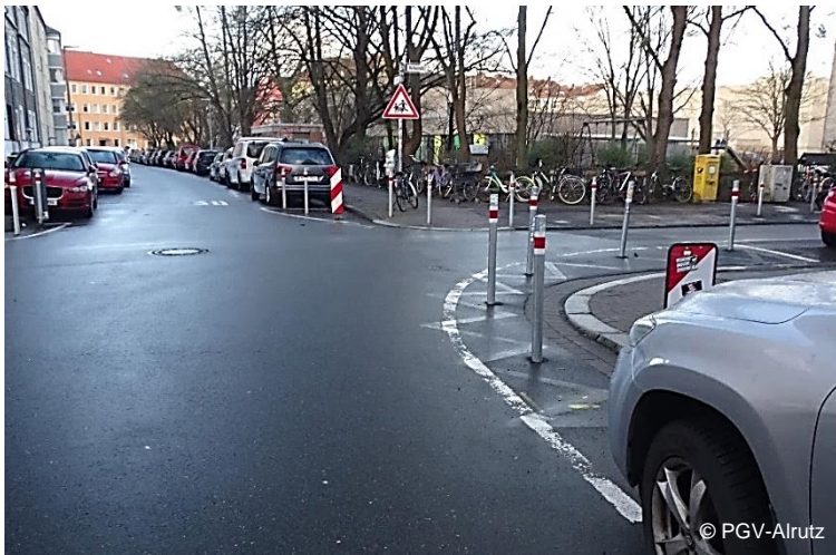
Abb. 5-18: Freihalten der Eckbereiche eines Rechts-vor-Links-Knotenpunktes durch Pfosten
