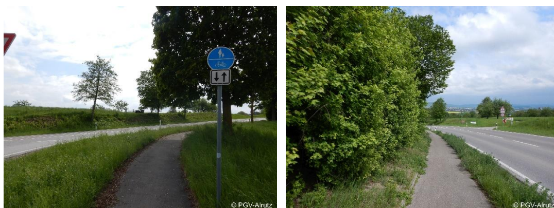
Abb. 5-30: Beispiel zu schmale Radverkehrsanlage außerorts (K 1028, Herrenberg)
