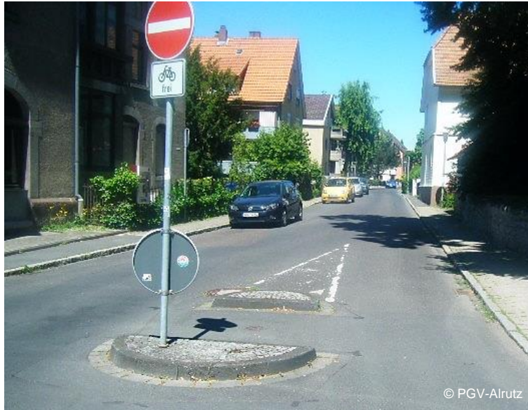
Abb. 5-14: Zugelassener Radverkehr gegen Einbahnrichtung mit „Einfahrtpforte“
