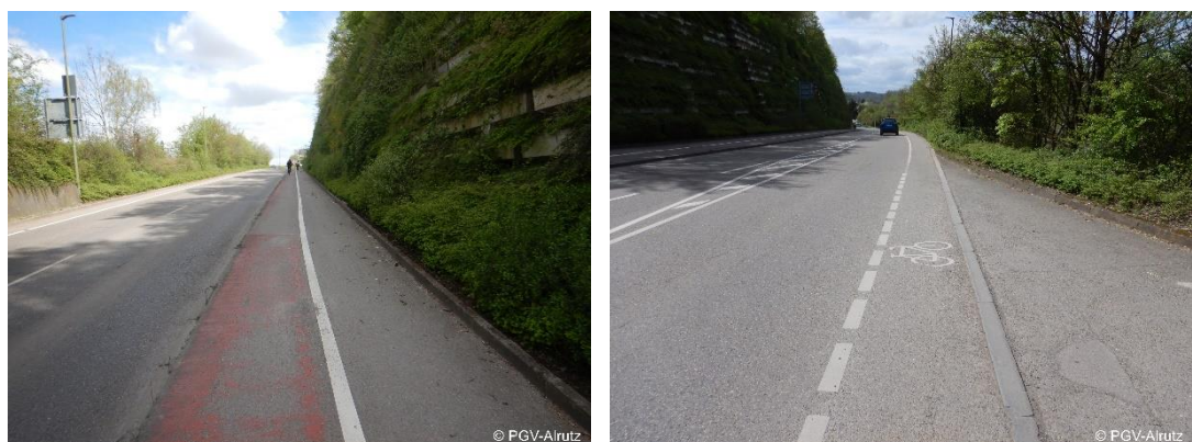
Abb. 5-28: Beispiel zu schmale Radverkehrsanlagen innerorts (Römerstraße, Leonberg)
