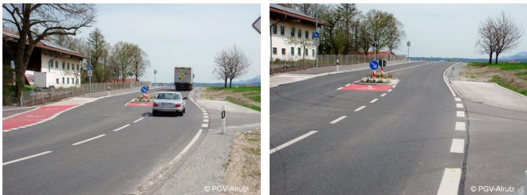
Abb. 5-36 Beispiel zur Gestaltung eines Ortseingangs mit Überführung des Radverkehrs von einseitiger Führung im Seitenraum außerorts in die richtungstreue Führung innerorts unter Berücksichtigung von zwei Querungsangeboten (Beispiel Rosenheim).
