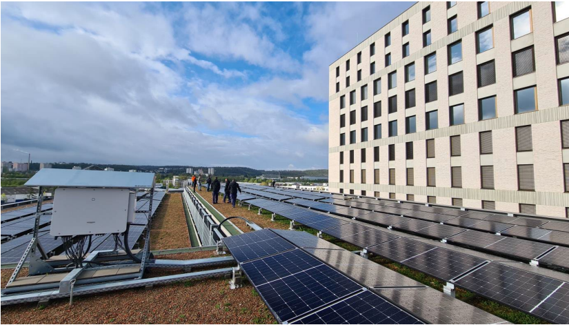
Abbildung 4: Einweisung und Abnahme PV-Anlage Parkhaus Ost
